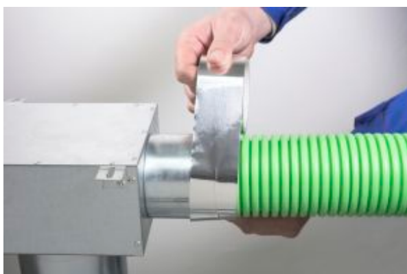
7) Spoj zajistíme vzduchotěsnou lepicí páskou.
