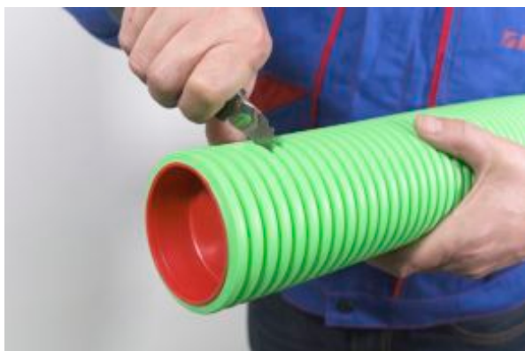
1) Trubku zkrátíme na požadovanou délku.
